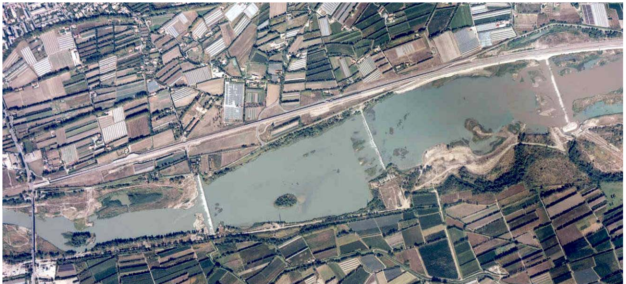
Photo 31 : Vue aérienne des seuils d'Avignon
