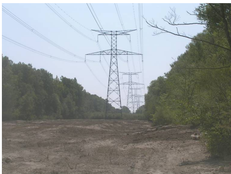
Photo 22 : Coupes à blancs sous les pylônes, dans la ripisylve de Saint-Estève-Janson (2004)
