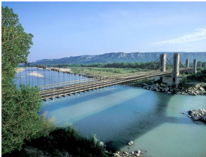
Photo 3 : L'ancien pont suspendu de Mallemort-Mérindol
